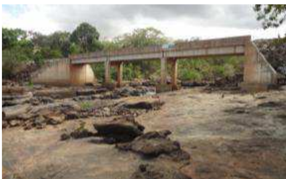
Figura 4: Trecho de vazão reduzida da PCH Pedra do Garrafão (1) Fonte: Elaborado pelos Autores (2015).
