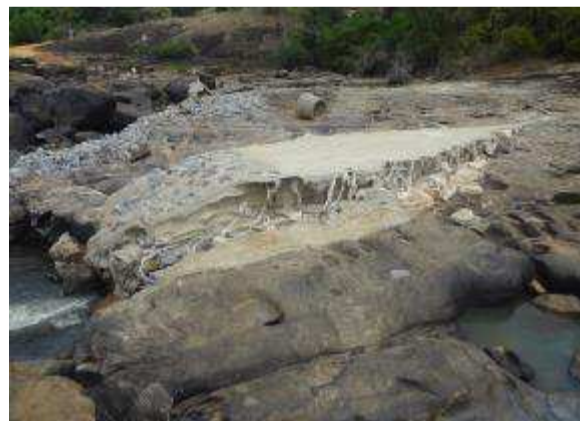
Figura 8: Pedras retiradas do leito do rio; material usado na construção do tanque (2). Fonte: Elaborado pelos Autores (2015).
