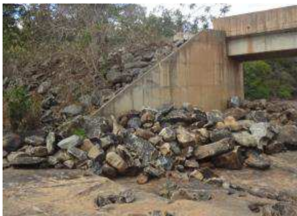
Figura 7: Pedras retiradas do leito do rio; material usado na construção do tanque (1). Fonte: Elaborado pelos Autores (2015).
